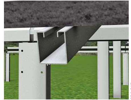
Bild 2: Stabilitätssteigernd wirken die besonderen C-förmigen Stahlprofile als Pfostenelemente.
